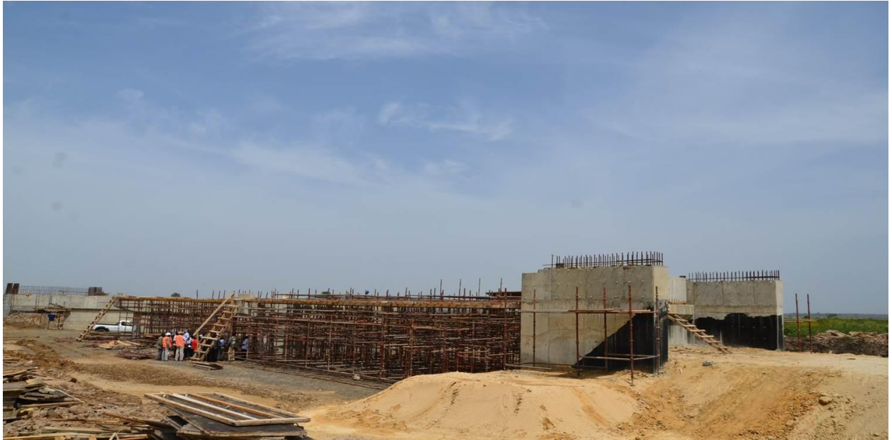
Daraja la Kariakoo linalojengwa katika barabara ya Bagamoyo – Msata eneo la Ruvu chini Mkoani Pwani
